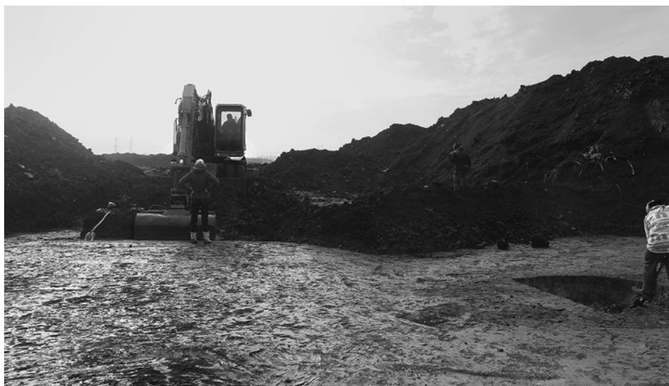
4. kép. Vékony rétegekben történő humuszosítás iszapolókanalas forgókotróval
