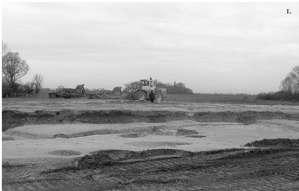
3. kép. 1. Réteges humuszolás szkréperládával a Nemesnádudvar-Hajósi úti dűlő II. lelőhelyen 2. Humuszolás iszapolókanalas markolókkal a Nemesnádudvar-Hajósi úti dűlő II. lelőhelyen
