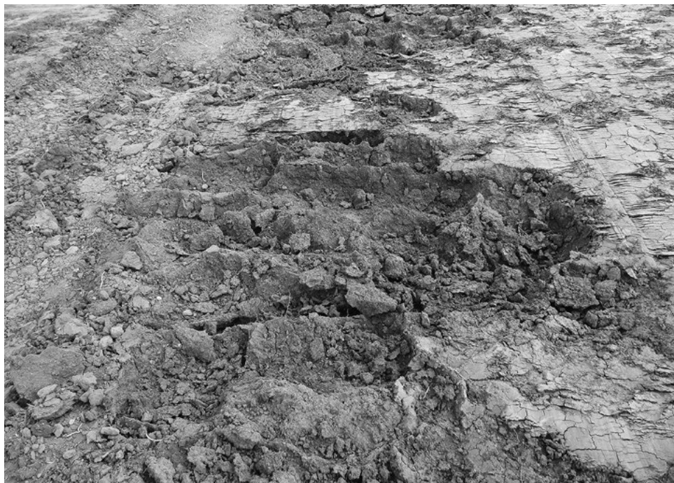
4. kép. Humuszoslási szkréperládával – az összetömörödött talajréteg felszaggatása, Bükkábrány, 2015
