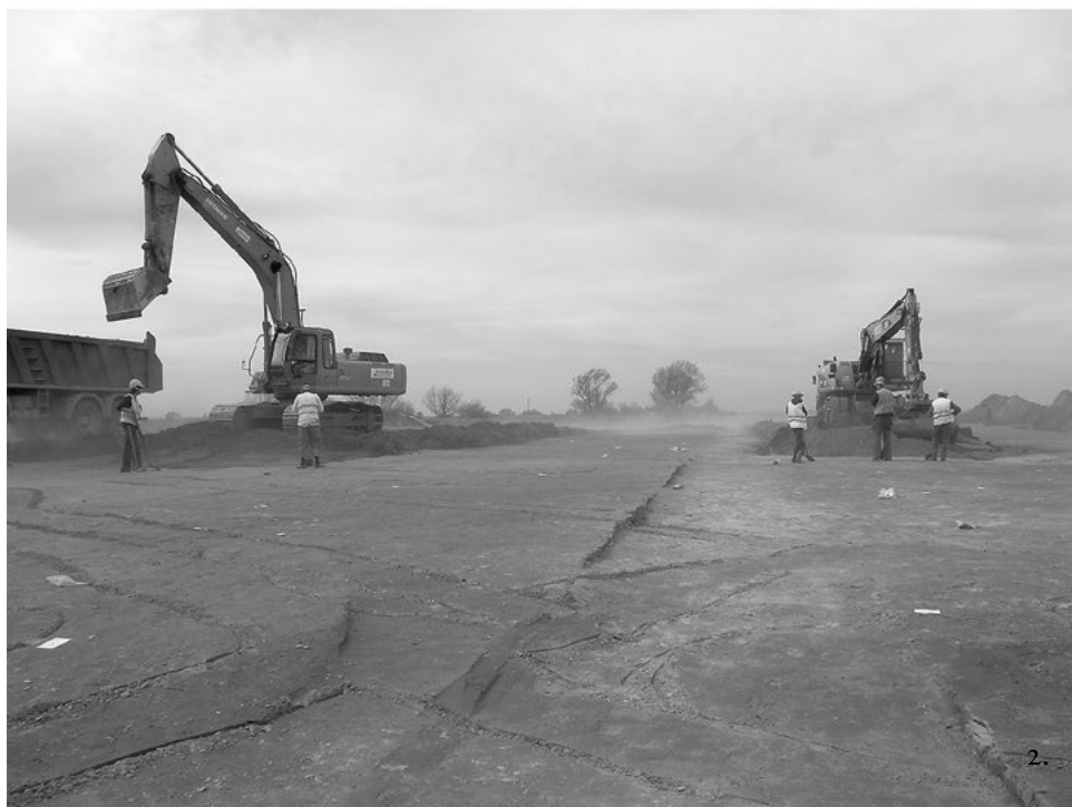
3. kép. 1. Réteges humuszolás szkréperládával a Nemesnádudvar-Hajósi úti dűlő II. lelőhelyen 2. Humuszolás iszapolókanalas markolókkal a Nemesnádudvar-Hajósi úti dűlő II. lelőhelyen
