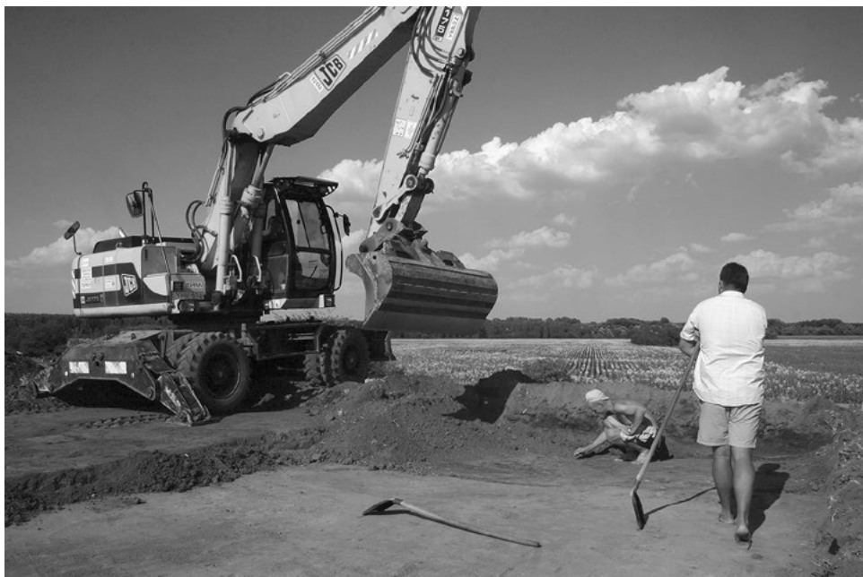
6. kép. A humusz helyes, réteges eltávolítása, Baks, 2006
