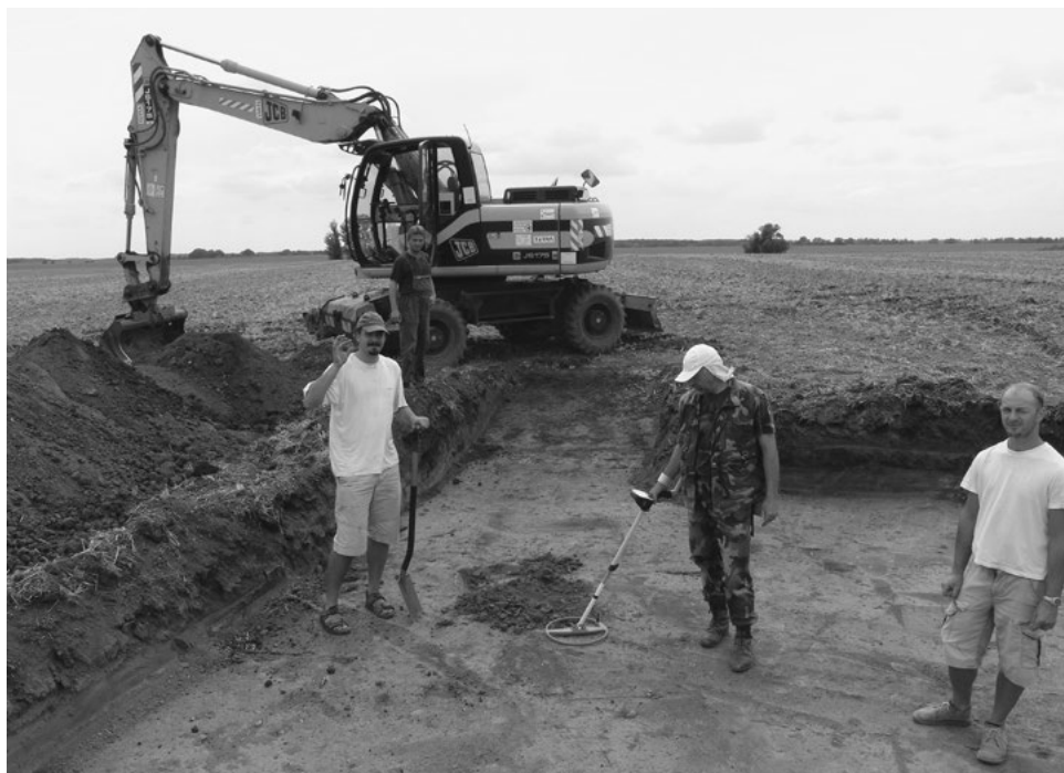
2. kép. Humuszréteg eltávolítása iszapolókanalas forgókotróval, Baks, 2008
