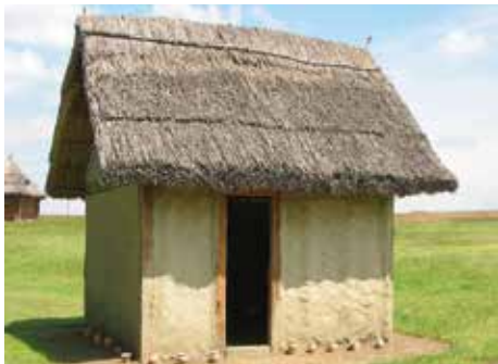
CÖLÖPSZERKEZETES HÁZ REKONSTRUKCIÓJA. BERZSENY FALU, KISROZVÁGY. FOTÓ: WOLF MÁRIA
