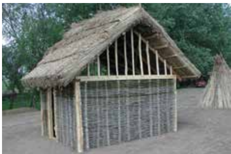
CÖLÖPSZERKEZETES, SÖVÉNYFALÚ HÁZ ÉPÍTÉS KÖZBEN. BERZSENY FALU, KISROZVÁGY. FOTÓ: WOLF MÁRIA
