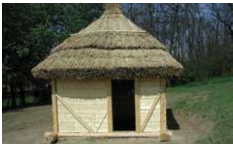
TALPAS-VÁZAS, ZSILIPLELT FALÚ HÁZ MEGÉPÍTETT REKONSTRUKCIÓJA. BERZSENY FALU, KISROZVÁGY. FOTÓ: WOLF MÁRIA
